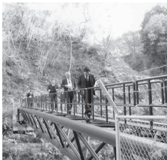
松川を渡る中山水管橋
