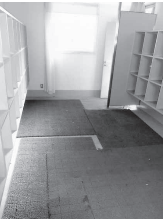
高山中学校プール更衣室
