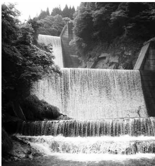
小水力発電所を建設予定の高井砂防ダム。
