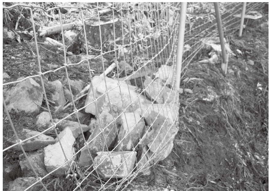
熊、イノシシに掘り起こされないように野石を積み重ね侵入を防いでいる。電気柵下部の金網折り返し箇所。
