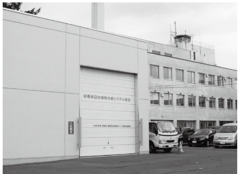
町役場に設置してある木質ボイラー室。役場の他、社会福祉協議会の施設などにも温水を供給している。（北海道下川町）
