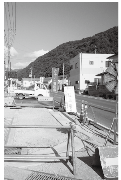
千本松のチェーン着脱場の歩道工事。思いの外早く着工しました。
