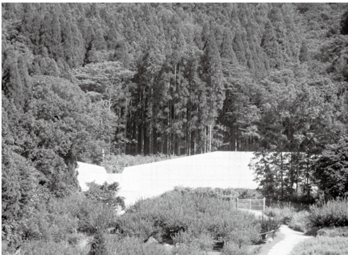
滝の入砂防堰堤。
