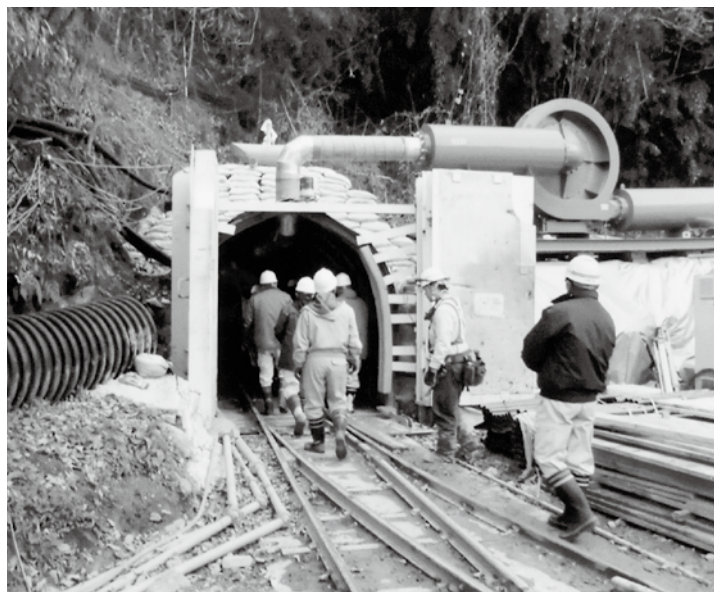
中山工区水路トンネル工事。(藤沢橋からなかひら) 中山地区受益46haの灌漑のために、水量確保、維持管理の軽減化、耕作放棄地の防止を図る。延長601m。
