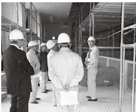
中学校体育館の天井工事の視察。
