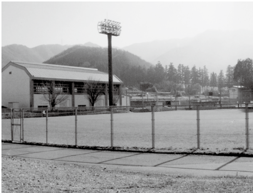
50戸の応急住宅が建てること出来る高井運動場。
