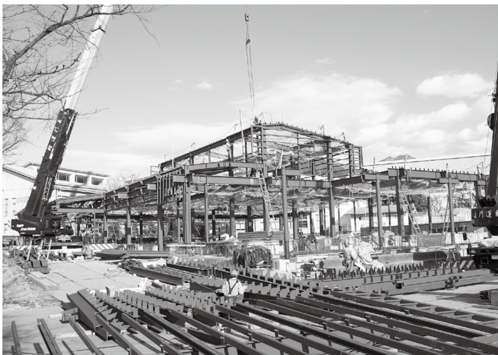
安全・安心な給食の提供と食育拠点、災害用炊出しを備えた、給食センター工事に着手。
