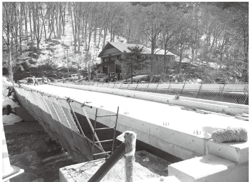
建設中の七味温泉橋橋梁工事。
