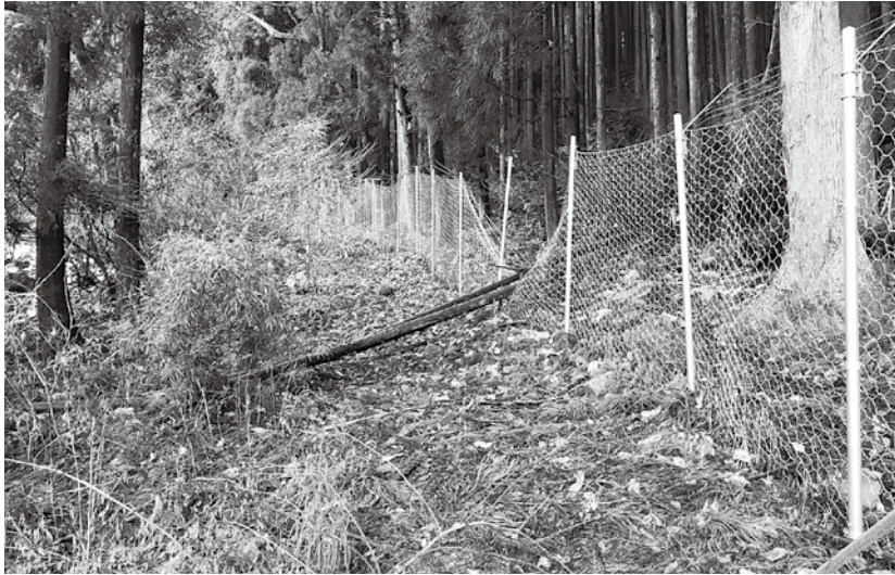
電気柵の倒木被害。
