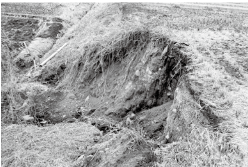
水田の畦畔の崩落21か所、畑、のり面の崩落14か所。
