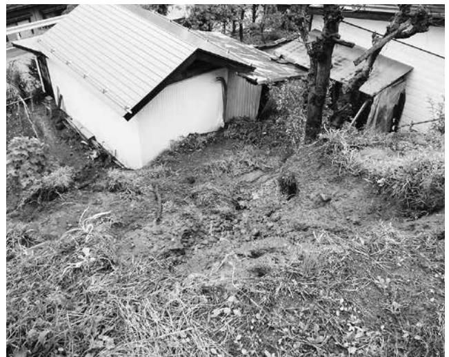
水田の畦畔の崩落により、倉庫に土砂が流入し堆積。
