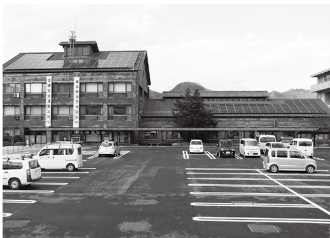
庁舎部屋に太陽光発電パネルを設置しました。
