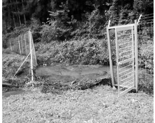
山林からの土砂の流出や倒木等で恒久電気柵の損壊5か所。
