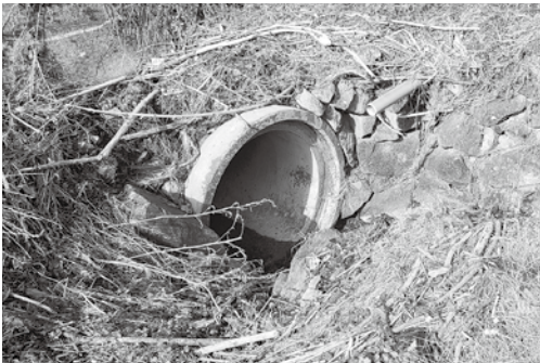
道路横断部分が直径1メートルのヒューム管。流木や土砂が詰まることが懸念される。
