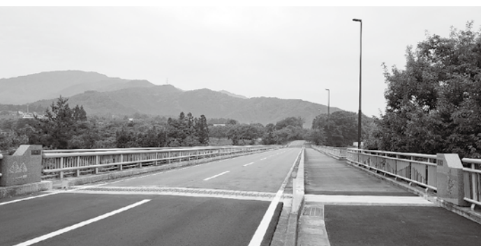
すでに補修工事がおわった、ゆうゆう橋。
