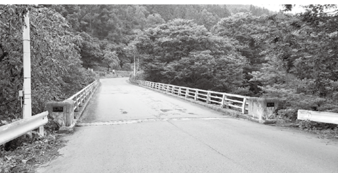
これから補修工事が、始まる藤沢橋。
