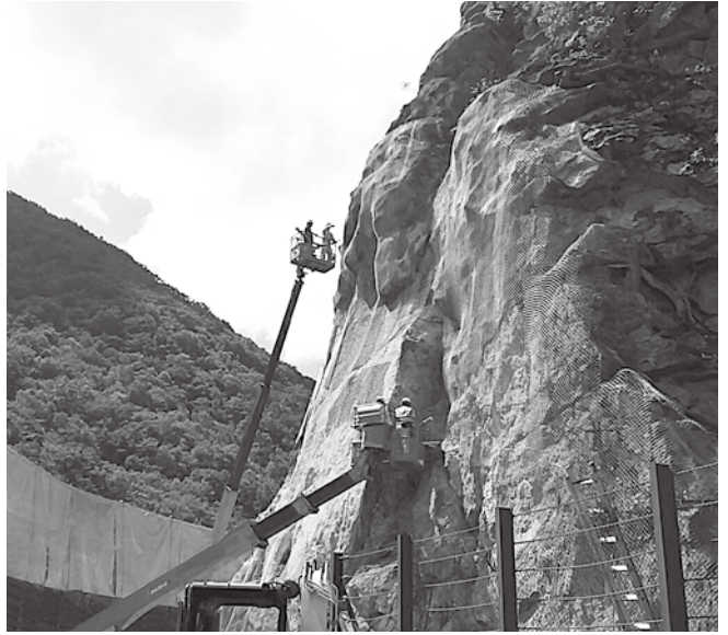
国土強靱化事業の作業写真（豊野南志賀公園線山田入）
