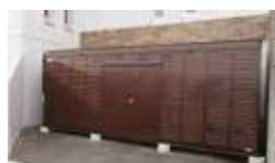
小学校正門横の防災倉庫。
