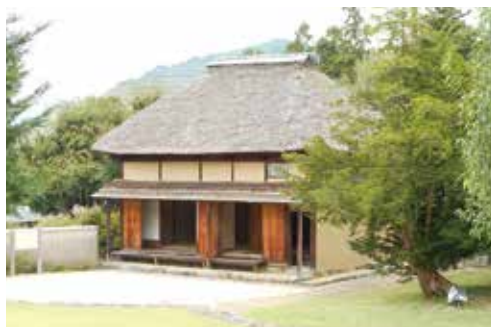
北側の茅葺きを修復予定の離れ家。
