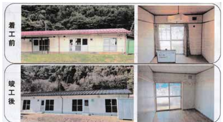
村営住宅改修の様子(資料より)
