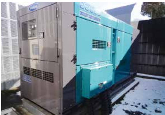
更新した発電機
