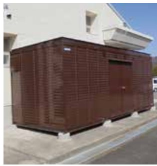
中学校体育館横の防災倉庫
