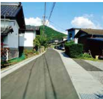
不動川豪雨災害による工事完了。
