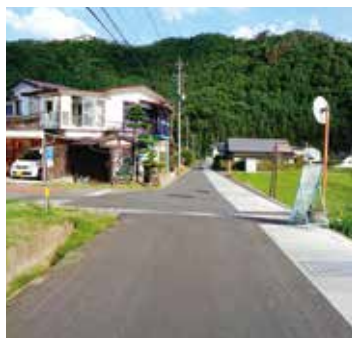
千本松豪雨災害工事。
