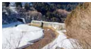
松川砂防堰堤。
