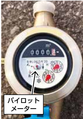
水道メーター
