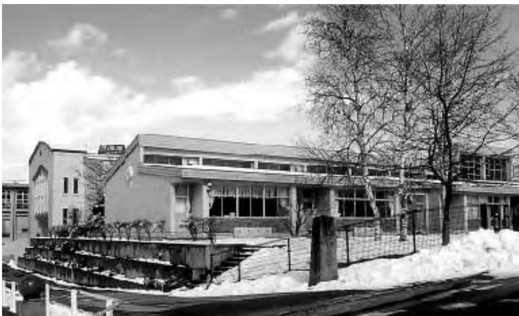
施工が予定される太陽光発電（高山小学校）
