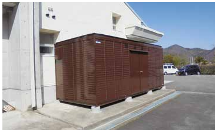
高山中学校体育館に設置した防災コンテナ
