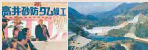
【昭和51年】高井砂防ダム竣工
