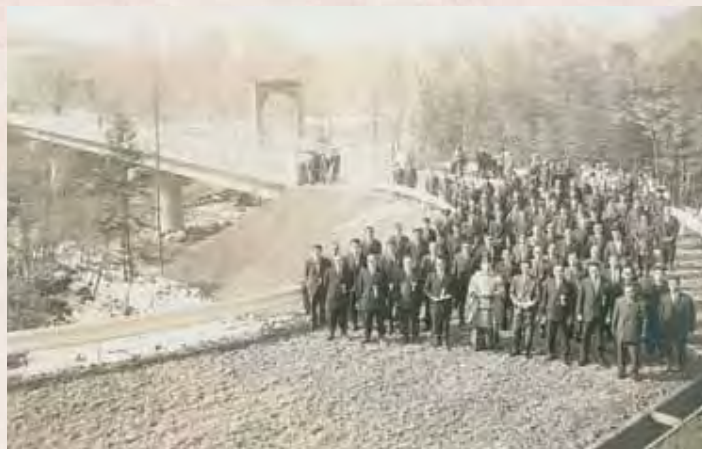
【昭和42年】沖渡橋永久橋架設工事竣工
