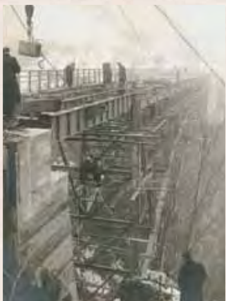
【昭和33年】高井橋建設工事
