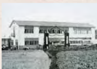
【昭和32年】完成した役場庁舎
