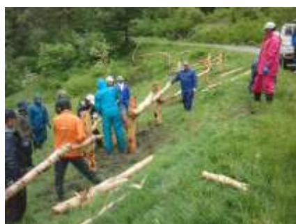
白樺柵設置作業
