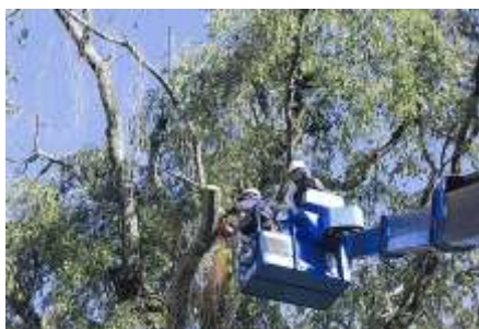
枯れ枝の伐採作業
