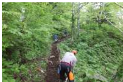
遊歩道整備作業
