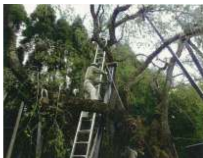
支柱の取り付け作業
